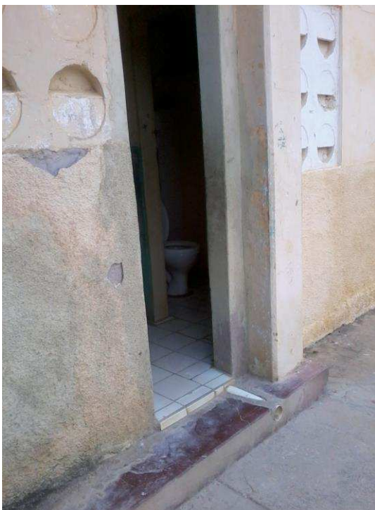
(Figura 17. Banheiro sem rampa)
