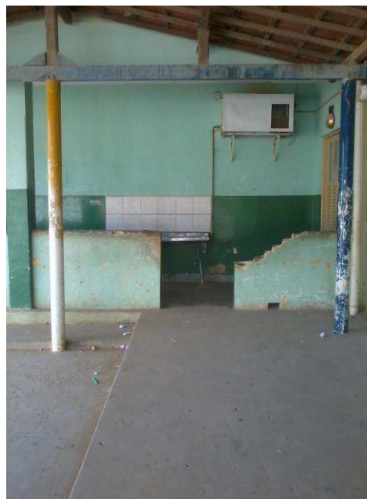
(Figura. 20. Acesso as salas de aula c/ rampas)
