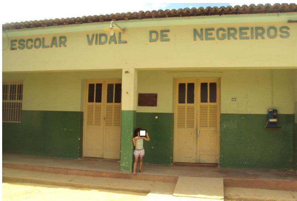
Figura 13. Entrada da escola com rampa de acesso
