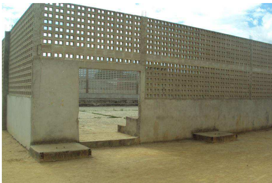
(Figura16. Ginásio em construção)
