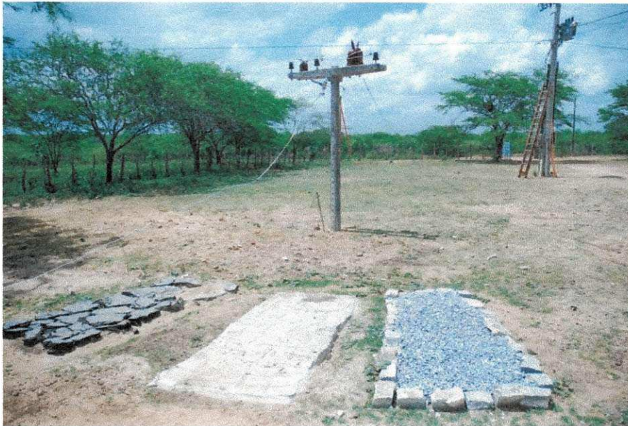
Figura 3.4 - Estrutura montada para realização dos ensaios.
