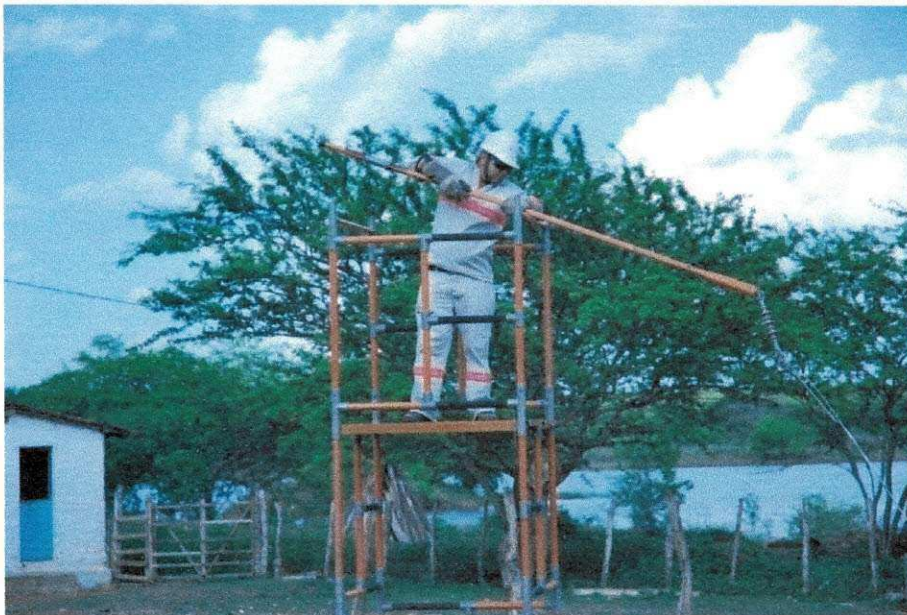
Figura 3.5 - Eletricista de linha viva manobrando o condutor.
