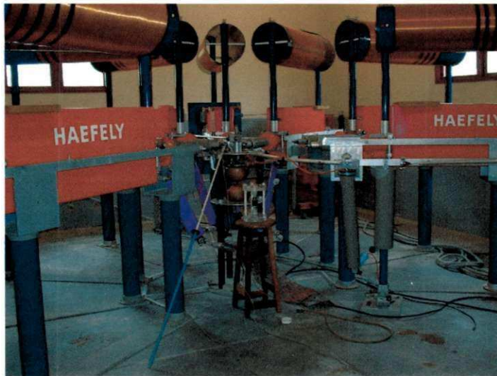
Figura 3.6 - Gerador de impulso de corrente
