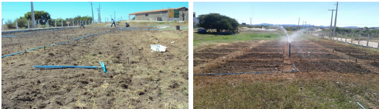
Figura 3: Montagem do Sistema de irrigação por aspersão.
