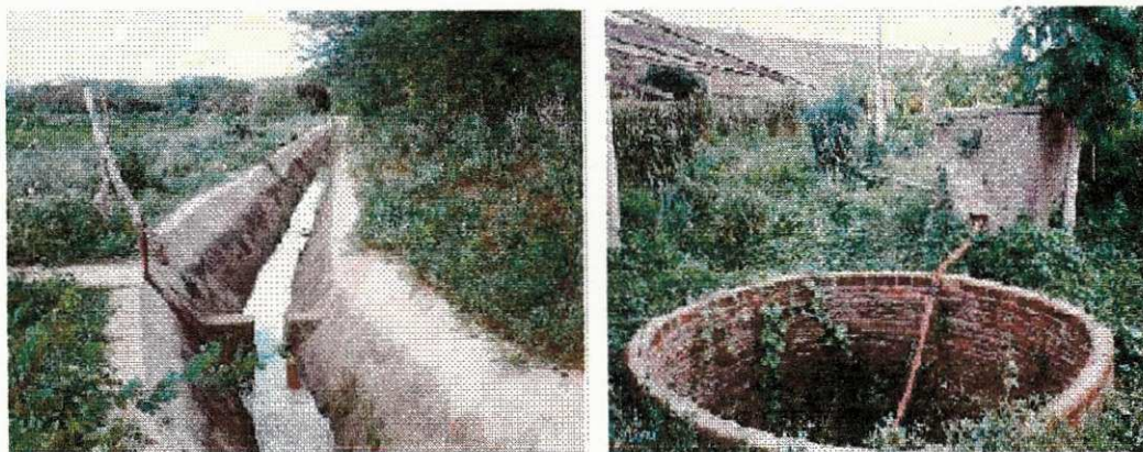
Figura 3.6 – Canais de irrigação e poços amazonas do Perímetro de Condado
