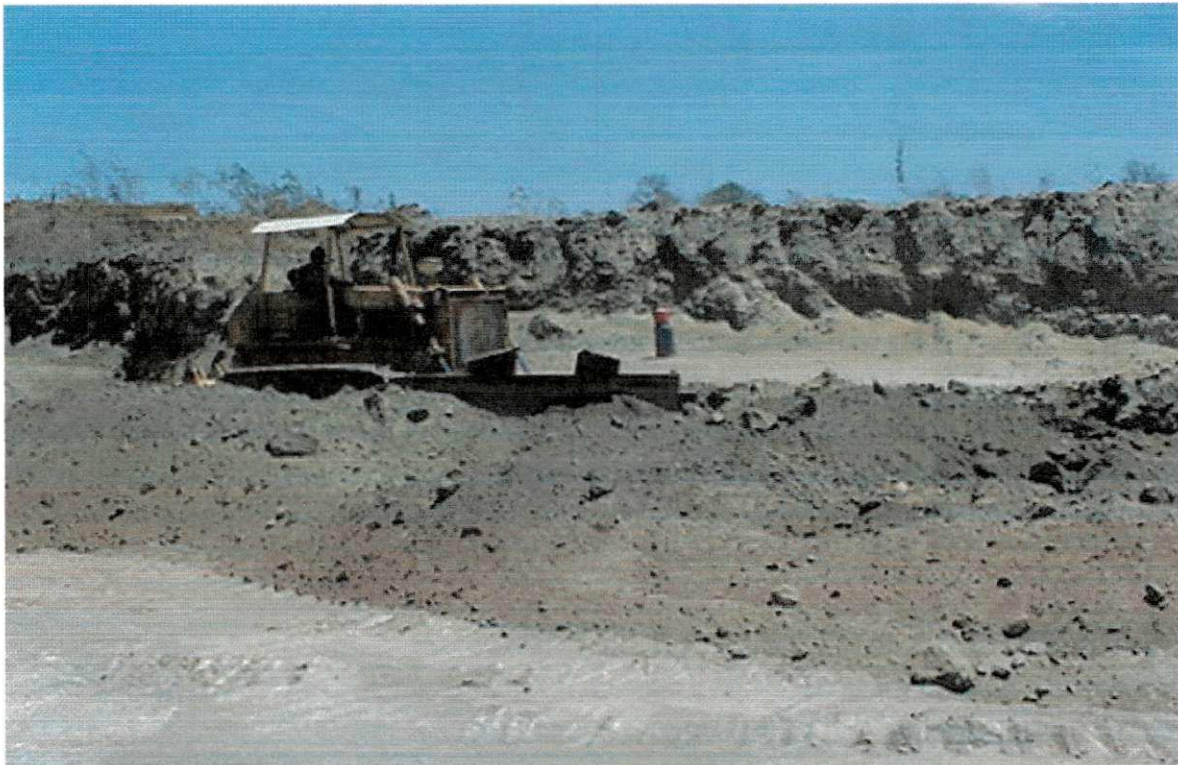
FIGURA 7 - Operação de decapeamento da lavra 01 usando um Fiat AD 14 CS
