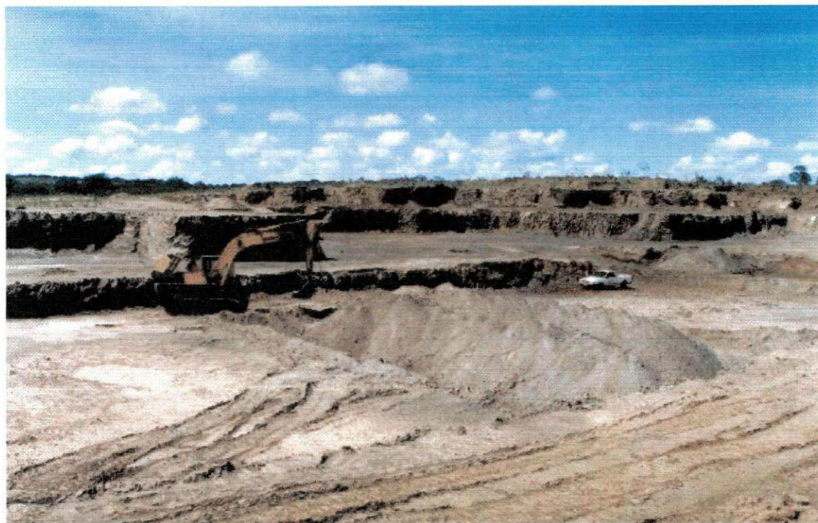
FIGURA 8 – Lavra da Cava Piloto vista norte
