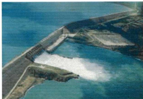
Figura I-2: Reservatório da Usina Hidrelétrica Luiz Gonzaga da CHESF
