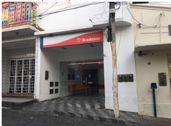
Figura 20– Agência do Bradesco, Rua José do Carmo Vale, Centro, 10/04/2019.
