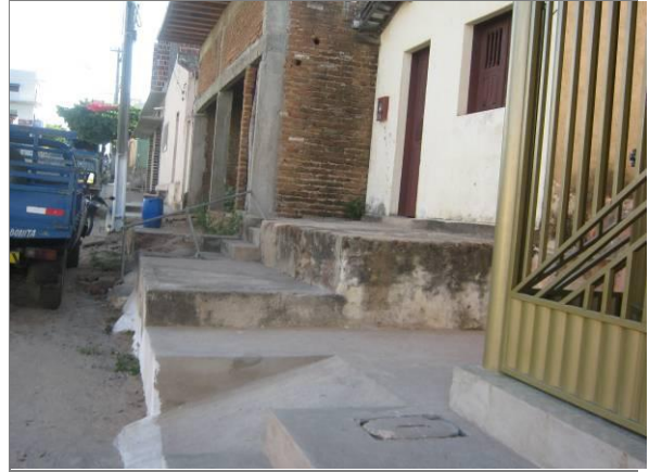
Figura 39—Calçadas desniveladas, o que dificulta o trânsito de pedestres, Rua Basílio Silva, Bairro Francisco Mendes (Vila Nova), 10/04/2019
