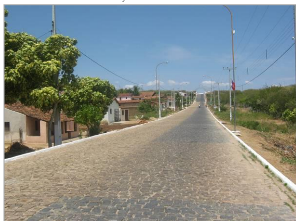
Figura 45—Rua Francisco Pereira Dantas, Rua do Portal, Via Principal de Entrada na Cidade Bairro Enéas Douettes, em paralelepípedo, sem calçadas e sem canteiro central, 10/04/2019.
