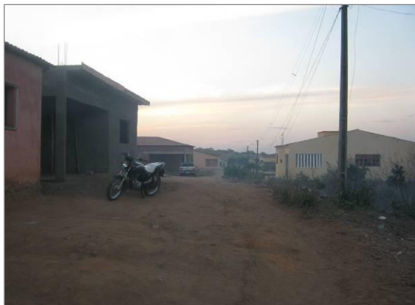
Figura 24–Falta de arruamento, edificações desalinhadas, Rua Raimunda Mendes dos Santos, Bairro Francisco Mendes (Vila Nova), 10/04/2019
