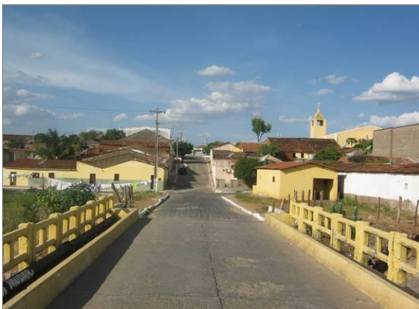
Figura 42—Ponte sobre o Riacho Égua Russa: Não existe passagem pra pedestre e só passa um veículo por vez, 10/04/2019
