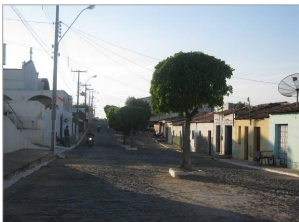
Figura 44—Rua Herculano Vieira, um dos eixos estruturantes do Bairro Francisco Mendes (Vila Nova), em paralelepípedo, 10/04/2019.
