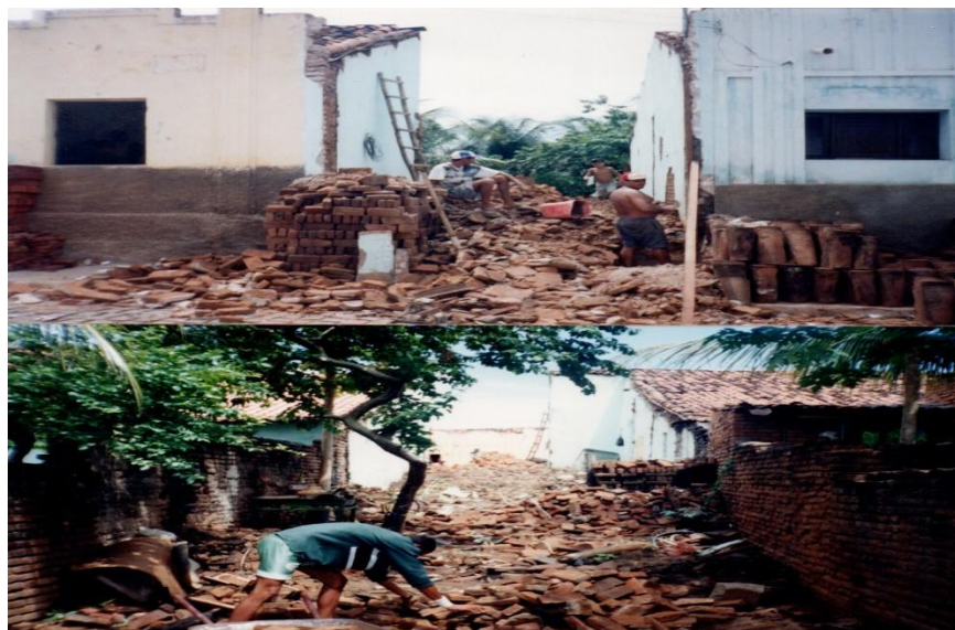
Figura 06 – Desapropriação de duas residências na rua Edmilson Cabral.
