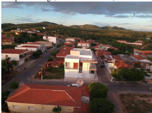
Figura 12–Casa de alto padrão construtivo, Rua José Marques Formiga, Francisco Mendes, 10/04/2019.
