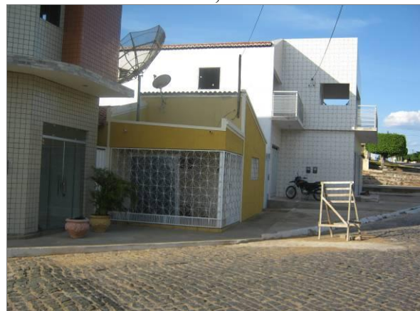
Figura 29– Edificações desalinhas em relação ao arruamento, Rua Beatriz Julia de Souza, Bairro Alto da Boa Vista, 10/04/2019
