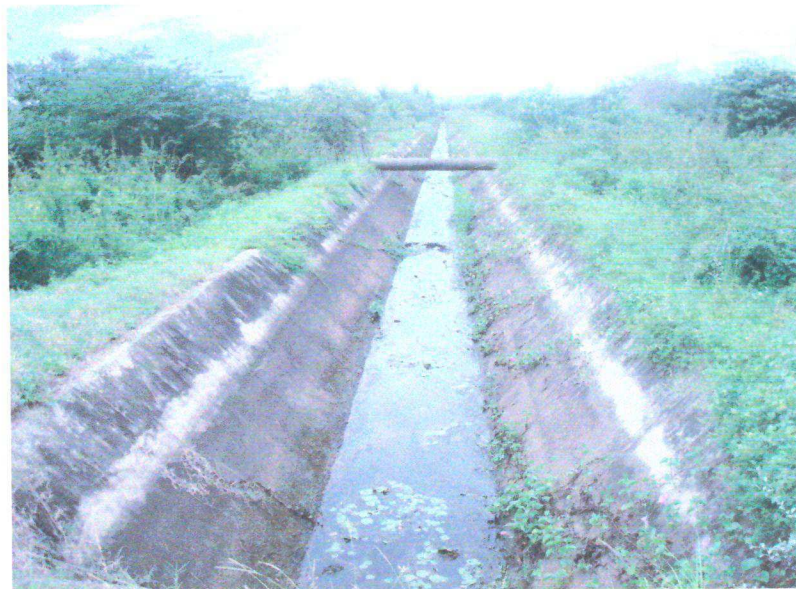
Figura 2 (H) – Vista do Canal Adjacente para irrigação
