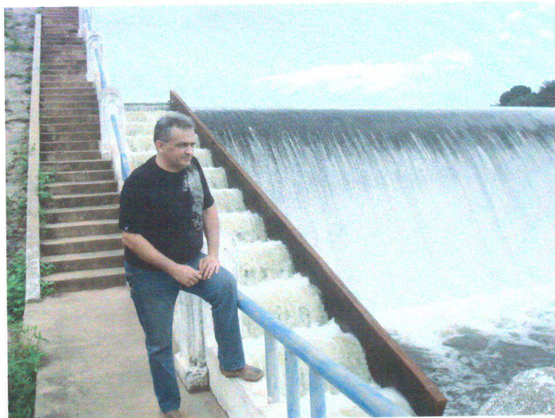
Figura 2 ( I ) - Vista do Sangradouro do Açude de S. Gonçalo com uma vazão de 12cm de lâmina d'agua.
