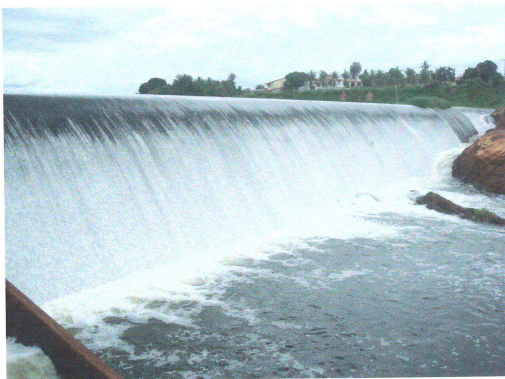
Figura 2 ( J ) – Vista completa do sangradouro do Açude de São Gonçalo
