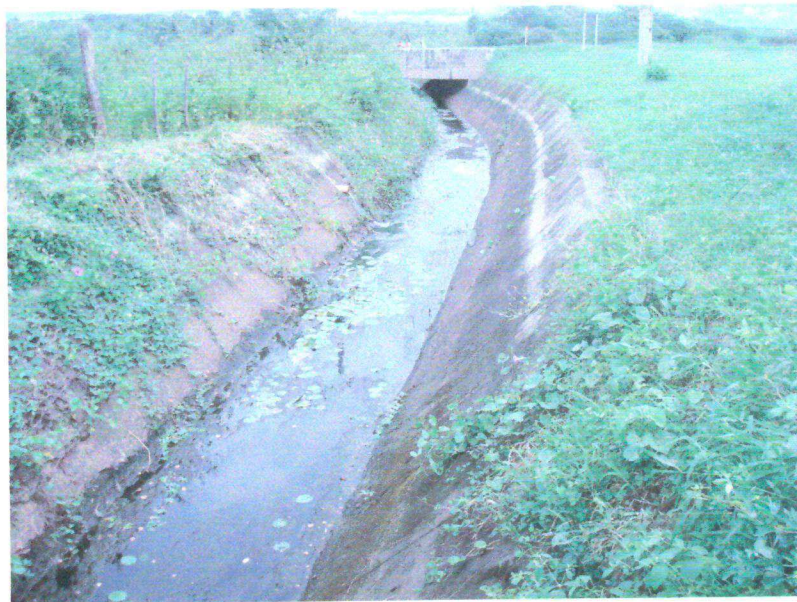
Figura 2 (G) - Vista do Canal Central de Irrigação
