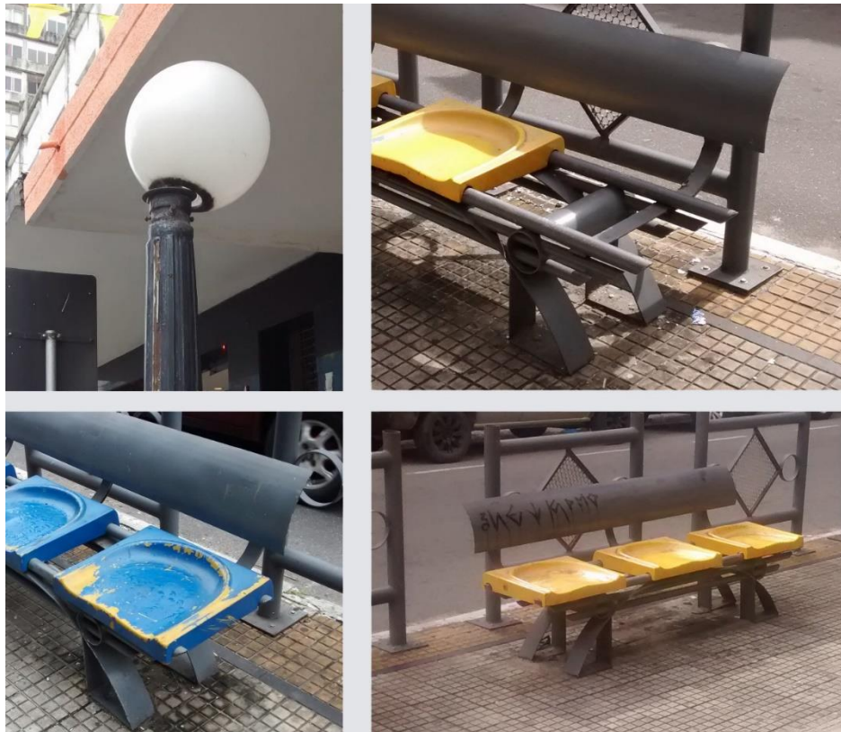
Figura 39: Mobiliário urbano danificado.
