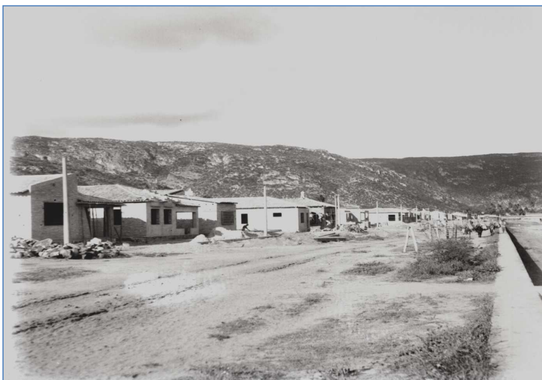
Imagem 7 - Avenida Orlando Oliveira Pires em construção em 1956.
