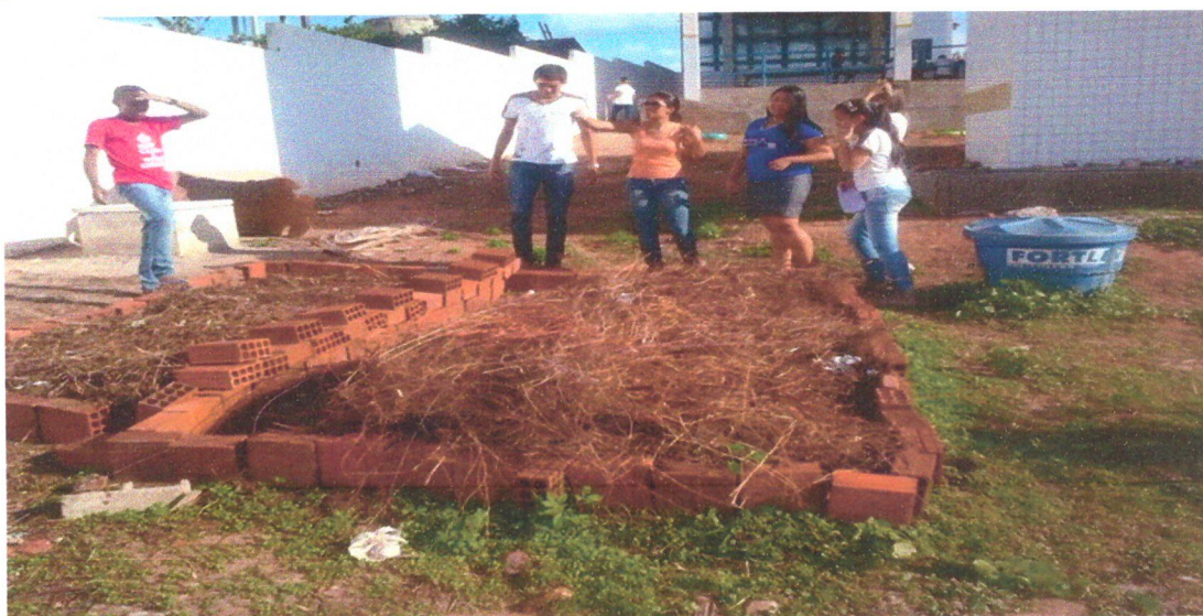
Figura 5 – Estrutura utilizada no processo de compostagem
