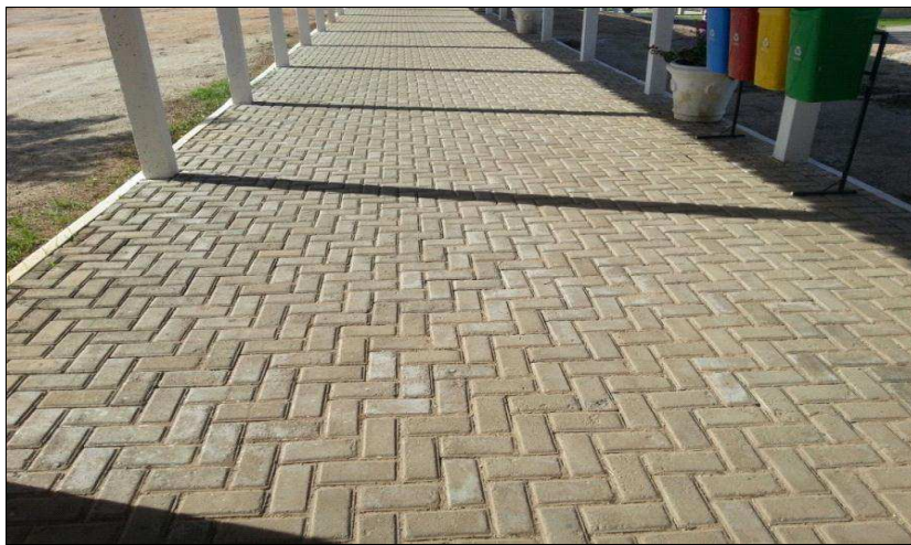
Figura 1 – Passarela do câmpus universitário em Pombal - PB.
