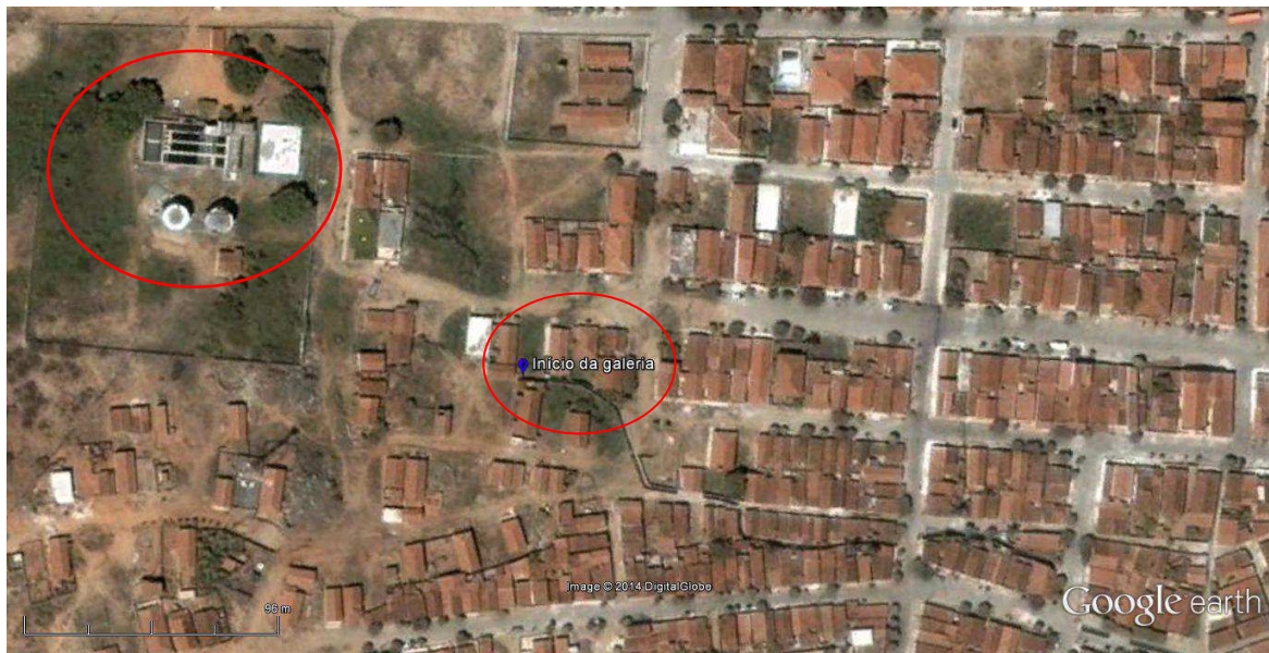
Figura 3 – Estação de Tratamento de Água de Pombal – PB
