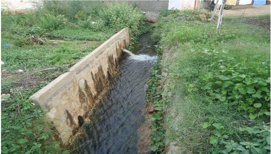
Figura 11 - Descarte do efluente de lavagem do filtro da ETA/Pombal
