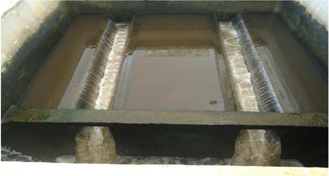
Figura 10- Lavagem do filtro ETA/Pombal
