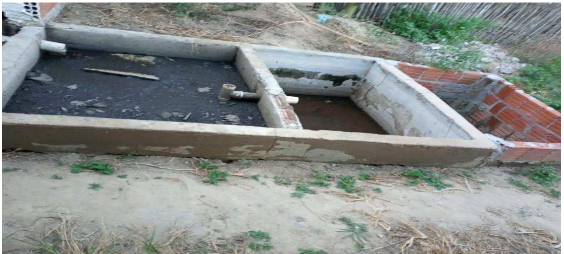
Imagem 03. Tanque de armazenamento dos dejetos suínos.
