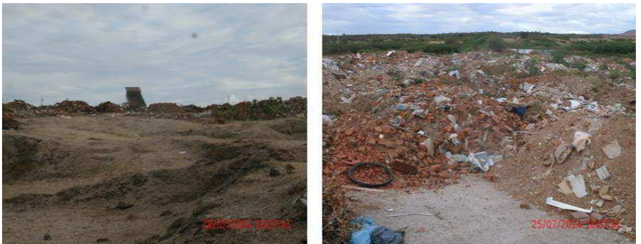
Figura 9 - Atividade de terraplanagem
