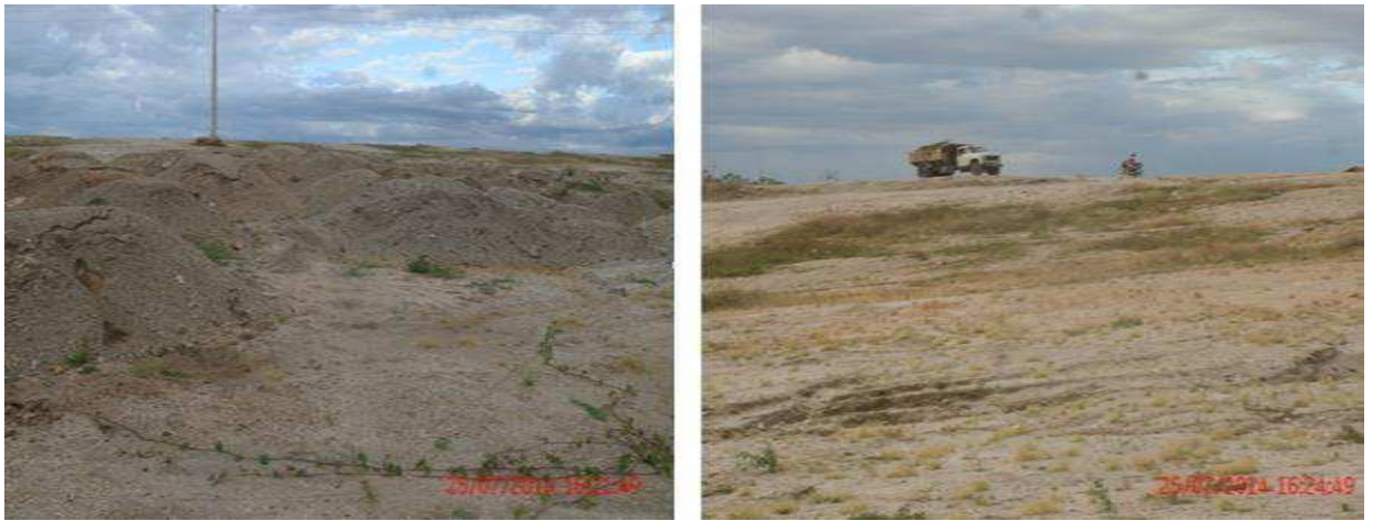
Figura 7 - Preparação do solo para o nivelamento
