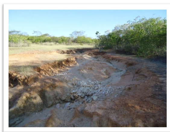
Figura 14. Erosão em forma de sulco em estágio avançado. Sítio Monte Alegre, junho de 2012. Localização: 37°44'50,634"W e 6°46'28,307"S
