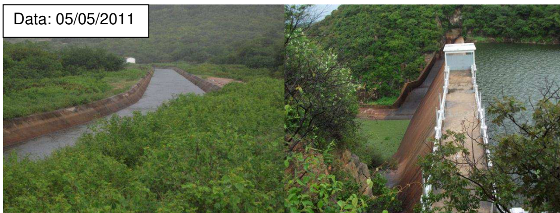
Figura 4 - Canal da Redenção, à esquerda, e a barragem do açude Mãe d'Água, à direita (Fonte: Autor).
