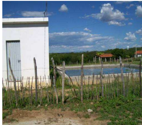
Figura 3. Tanque de alvenaria.
