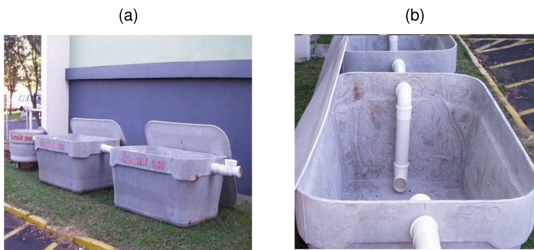
Figura 14. Componentes da fossa séptica biodigestora: (a) vista geral dos componentes montados; (b) vista interna do sistema.
