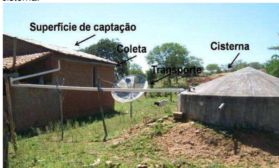
Figura 8. Sistemas de captação e armazenamento de água de chuva em cisterna.
