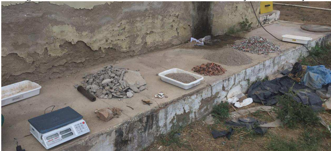
Figura 5: Fracionamento dos resíduos de construção e demolição
