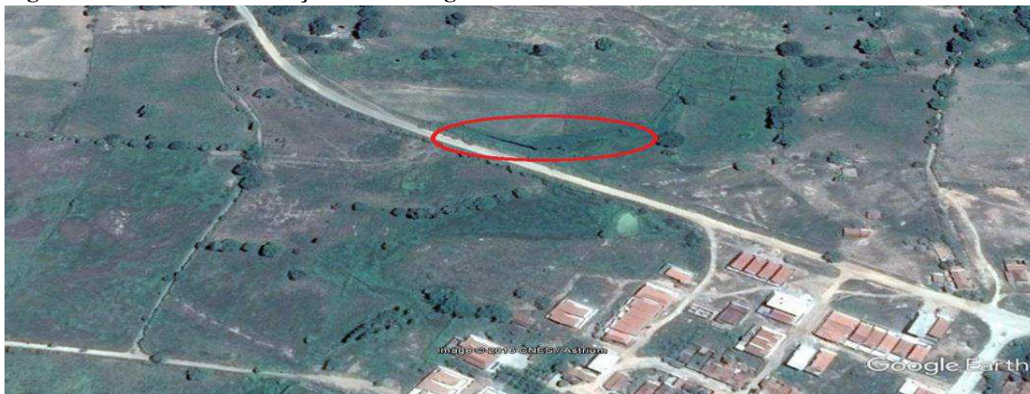
Figura 11 – Local de destinação final do esgoto da cidade.
