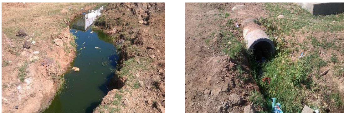
Figura 13 – Esgoto a céu aberto dentro da cidade.
