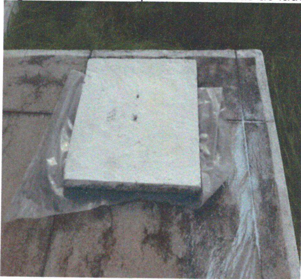
Figura 5 – Fossas sépticas localizadas ao lado da biblioteca
