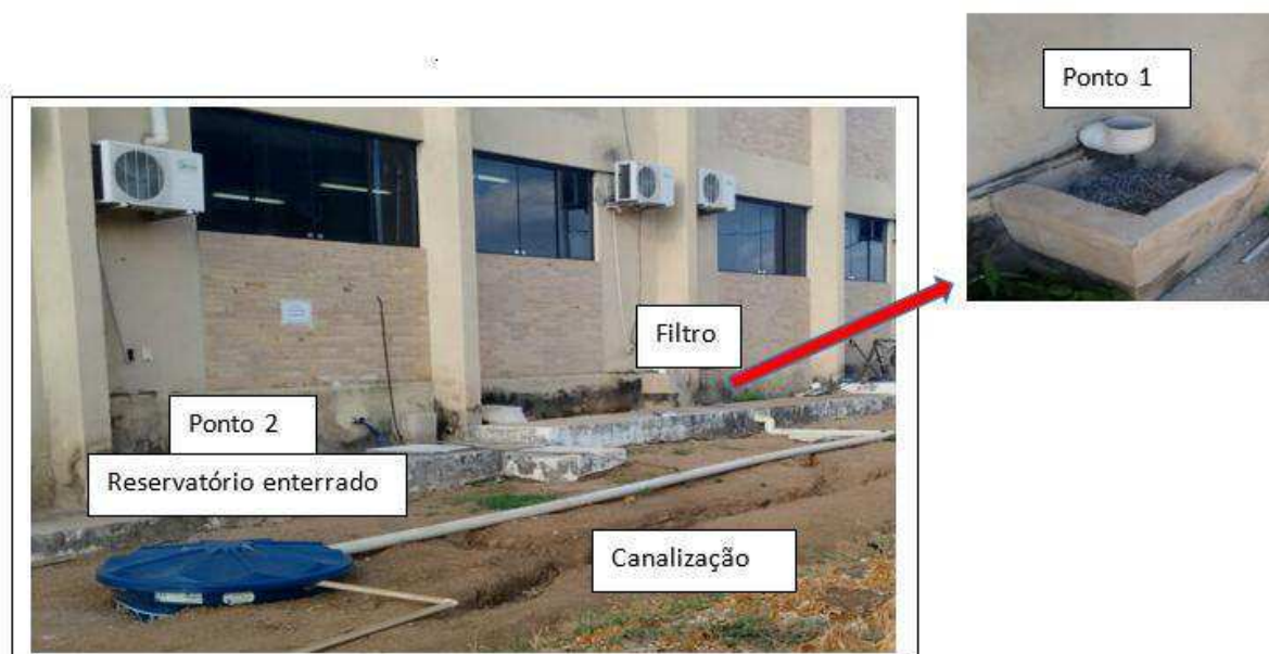
Figura 06- sistema de coleta de águas pluviais.
