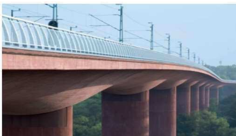
Figura 16 - Ponte em Concreto Colorido
