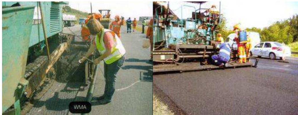
Figura 3 – Emissão de fumos na aplicação de uma mistura morna
