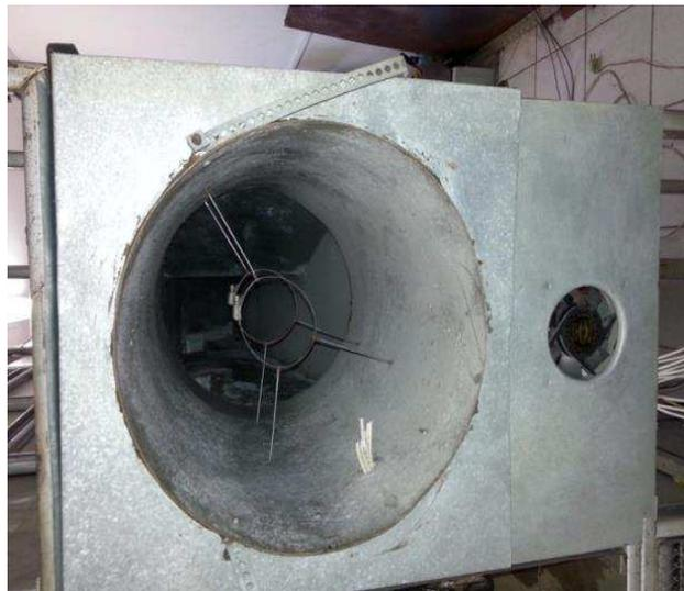
Figura 3.47 - Vista dos ventiladores com o grupo de resistências dentro do duto. Fonte: Autor (2017).
