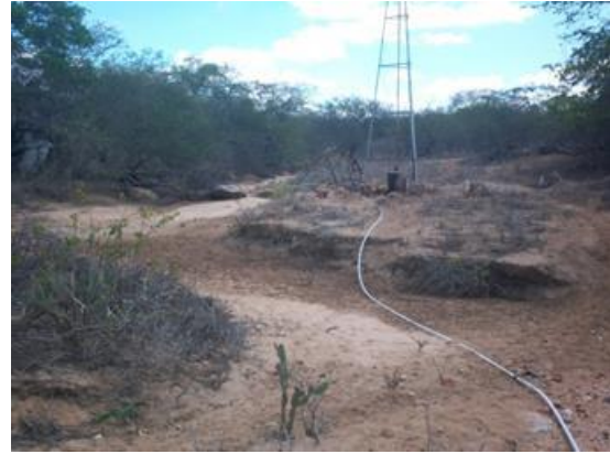
Figura 28. Tombamento do cata-vento ao fundo, pela corrosão
