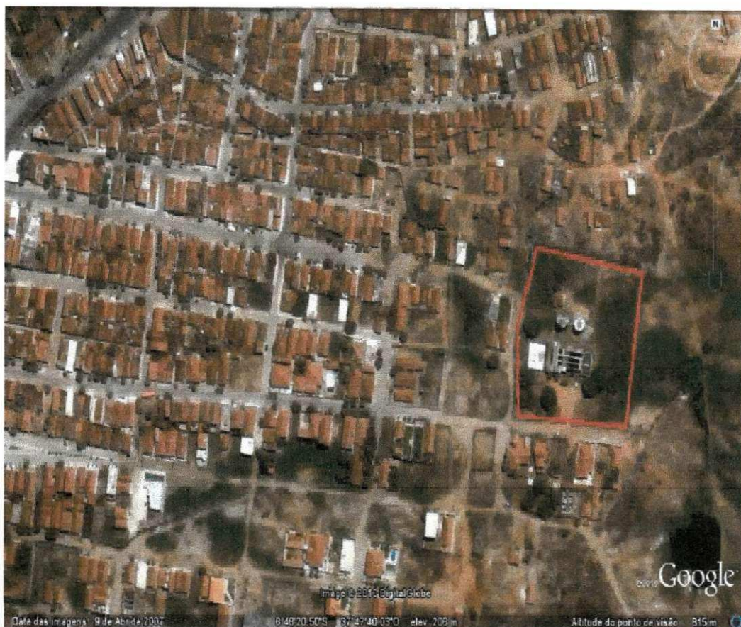
Foto 03: Estação de Tratamento de água da cidade de Pombal (ETA).
