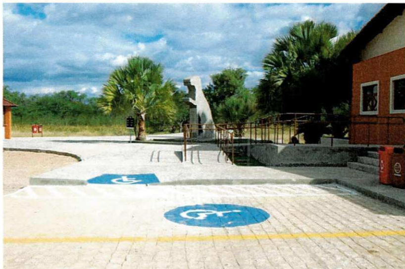
Foto 27 – Área para estacionamento, calçadas e rampas adaptadas para pessoas com necessidades especiais (Fotografia da Autora/junho de 2013).
