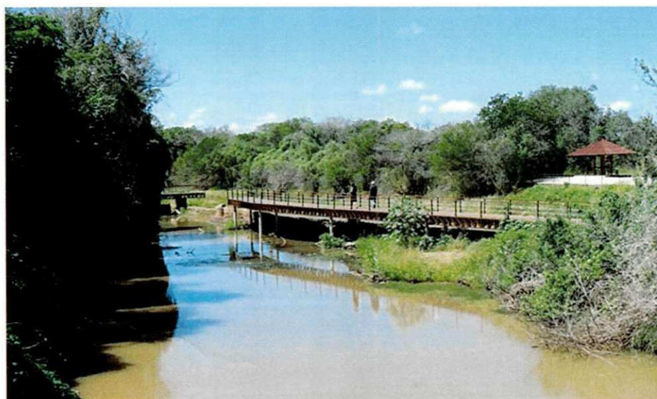
Foto 04 - Passarela de observação das pegadas (Fotografia da Autora/ abril de 2012).
