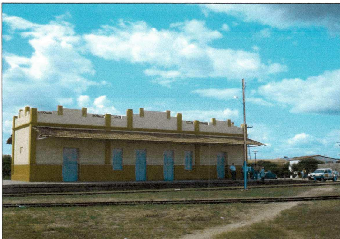
Fig. 2: Esse registro capta a visita dos técnicos do IPHAEP a Estação Ferroviária de Pombal.
