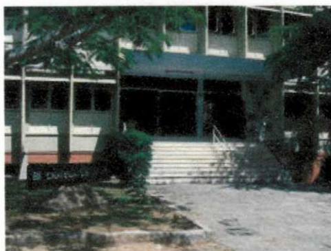
Figura 7 – Biblioteca Central da Universidade, Campus I, UFCG.
