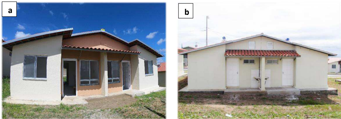
Figura 24 - Tipologia casa do complexo habitacional (a; b).
