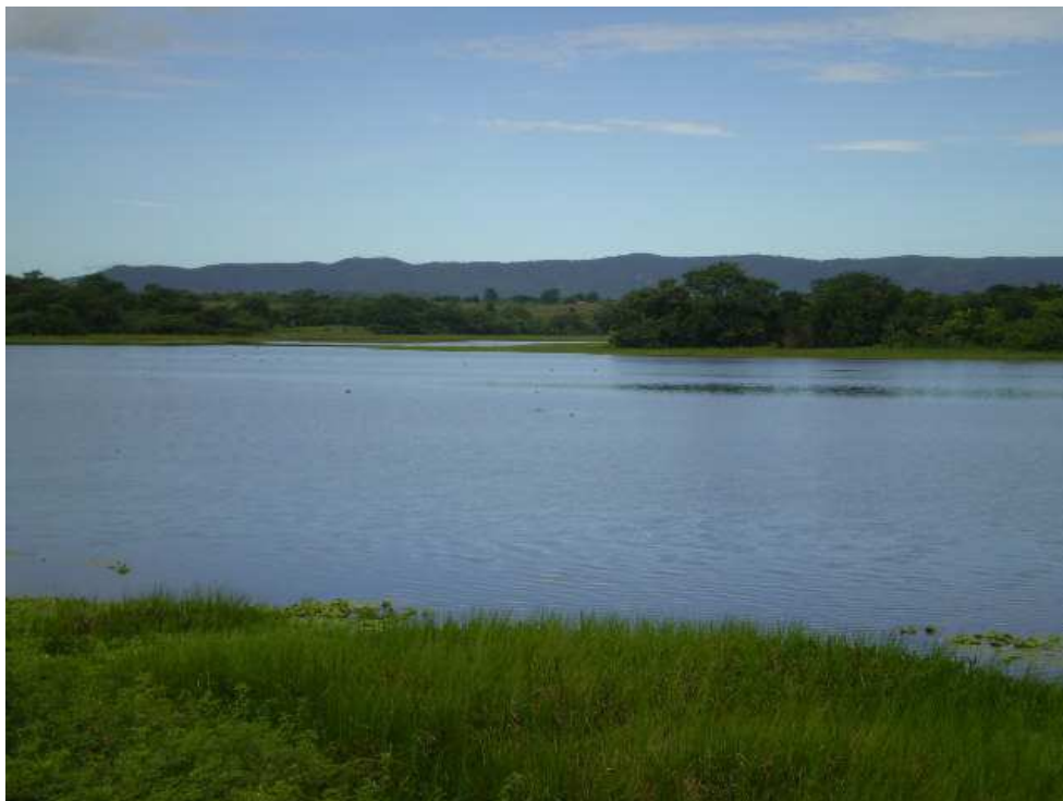
Fig. 6 - Açude “Soim” com capacidade de 6 milhões de m 3 de água (INCRA,1996).
