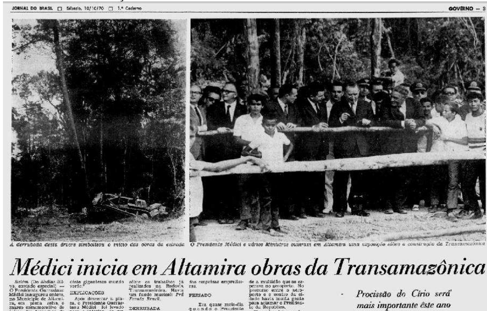
FIGURA 07 - Construção da Rodovia Transamazônica.
