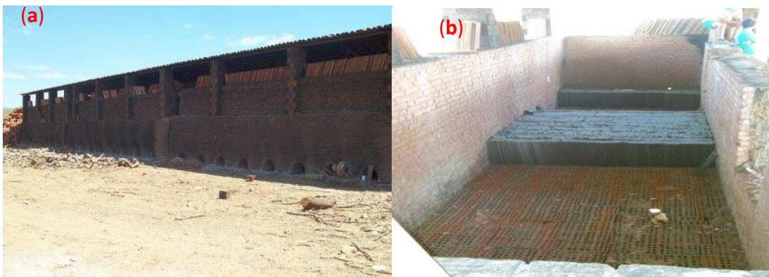
Figura 3 –Forno tipo “caipira”: Parte externa (a); Parte interna (b).
