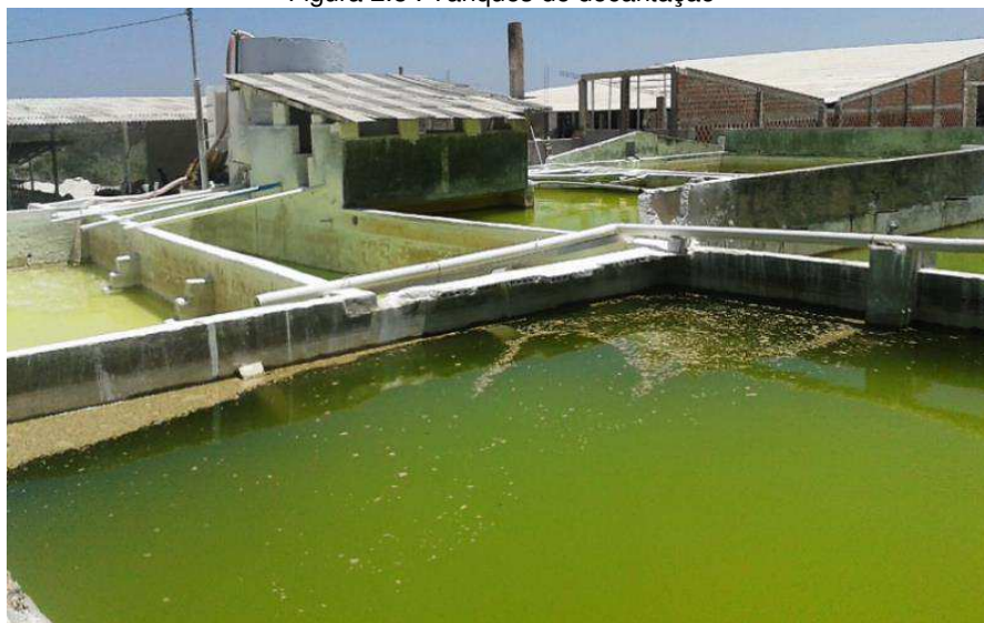
Figura 2.8 . Tanques de decantação
