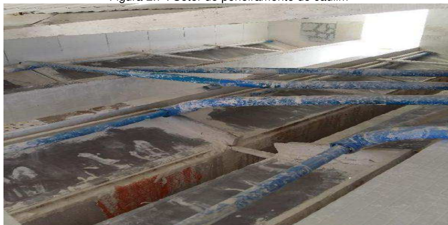
Figura 2.7 . Setor de peneiramento do caulim
