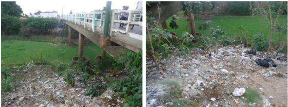
Figura 1(a) e 1 (b) - Disposição inadequada de resíduos sólidos no Município de Sousa - PB.
