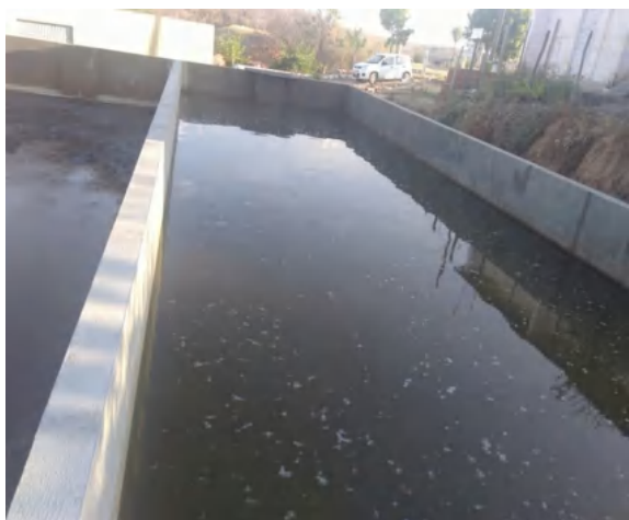
Figura 7 - Fase 01 Leitos drenantes cheios
