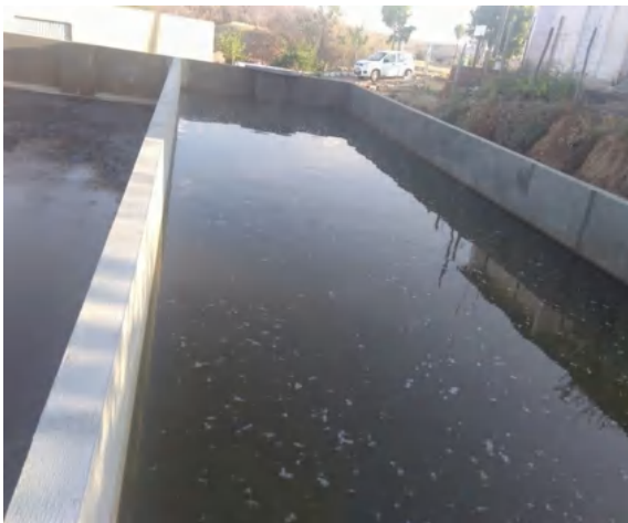
Figura 9 - Fase 01 Leitos drenantes cheios
