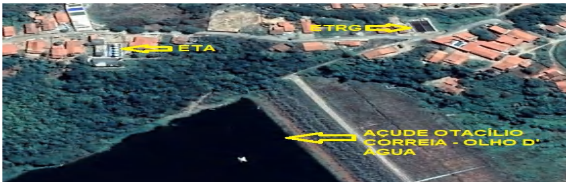
Figura 2 - Localização da Estação de Tratamento de Água do Manancial de abastecimento e de Estação de Tratamento de Rejeito Gerado em Várzea Alegre – CE
