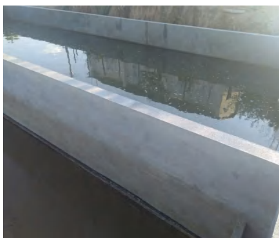
Figura 8 - Fase 01 Leitos drenantes cheios
