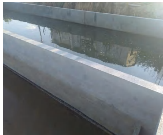
Figura 10 - Fase 01 Leitos drenantes cheios
