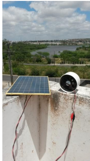
Figura 3.12. Cooler e o mini painel fotovoltaico.
