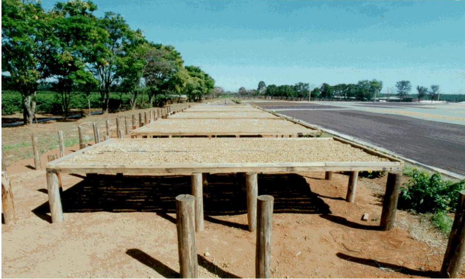
Figura 2.6. Secadores em telas suspensas, para secagem solar construído na UFV.
