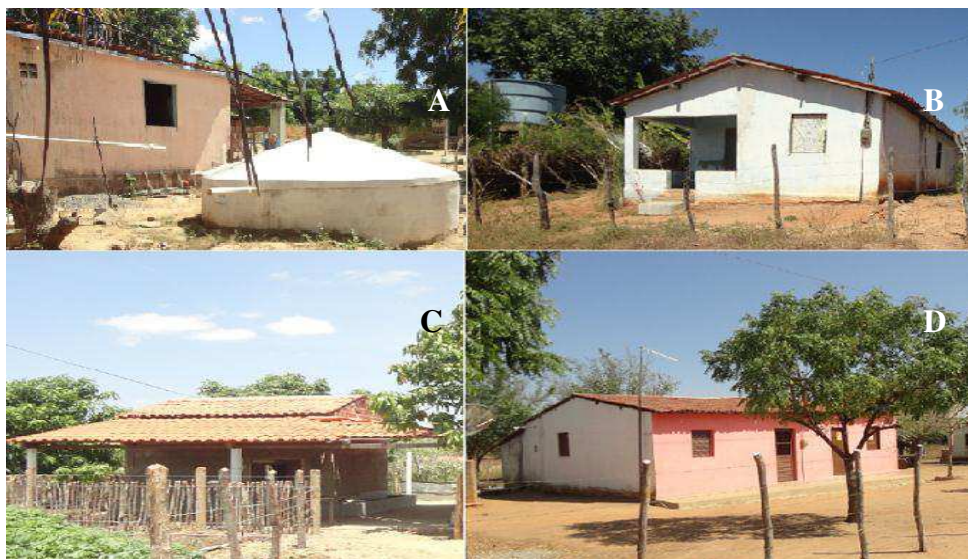
Figura 18 – Casas de alvenarias construídas pelo INCRA nos assentamentos: Edvaldo Sebastião, Mãe Rainha, Frei Beda e Santo Antônio
