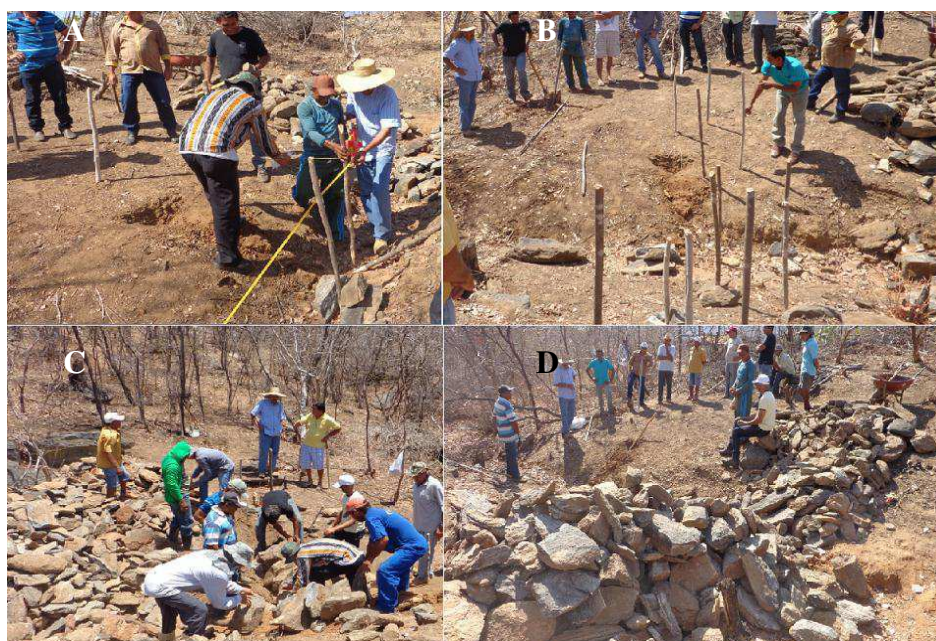
Figura 92 – Construção de barramento zero no assentamento Santo Antônio
