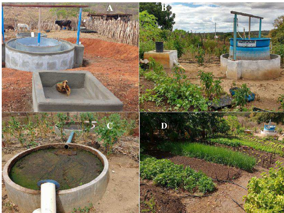
Figura 94 – Construção de biodigestor no assentamento Santo Antônio
