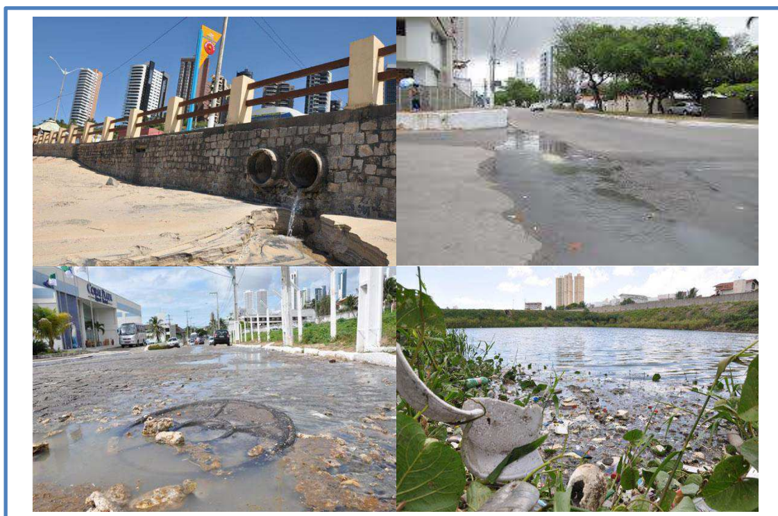
Figura 20 – Esgotos em Natal-RN
