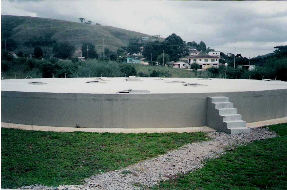
Figura 4.10 - Filtro anaeróbios da ETE Colombo, no Paraná, Brasil ( Q=30 l/s).
