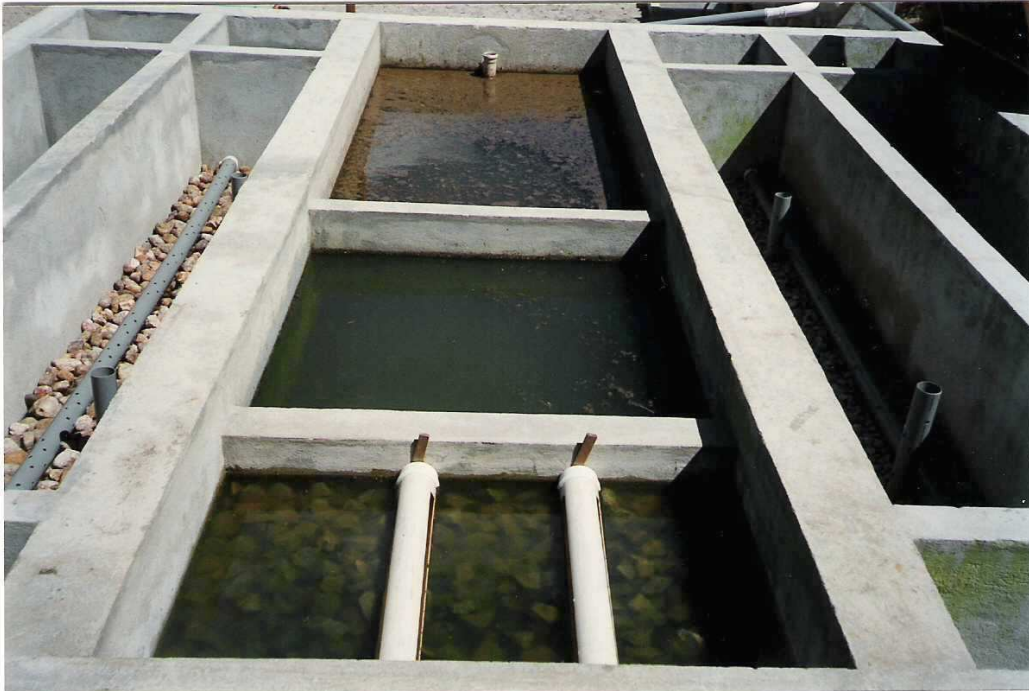
Figura 5.2 - Sistema compacto experimental. Decanto-digestor ao centro, com o pequeno filtro ascendente em primeiro plano, e dois filtros anaeróbios em cada lado.
