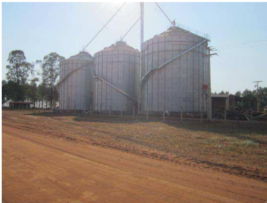
Figura 37 - Investimento em silos para armazenamento da produção
