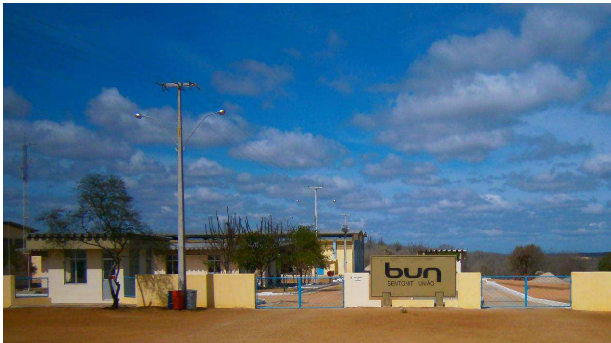
Figura 5: Vista da Empresa Bentonit- Pedra Lavrada-PB Fonte: Da pesquisa
