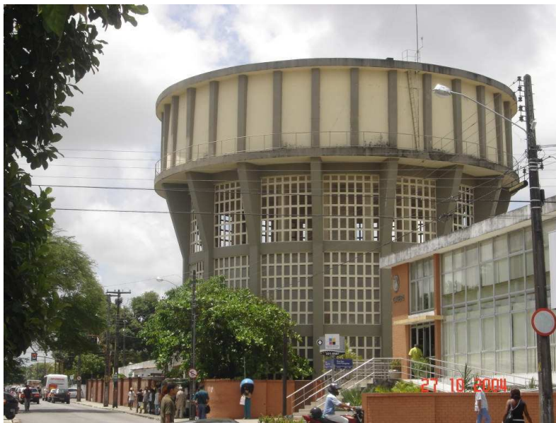
Figura 5.6 - Reservatório elevado (RE) do sub-sistema R1.
