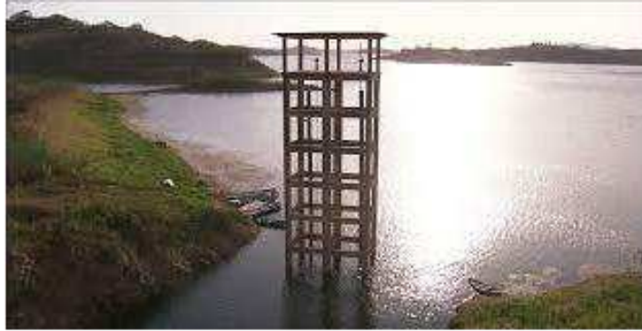
Figura 12 - Imagem da situação de diminuição do volume de água do açude Epitácio Pessoa Fonte: Imagem publicada em https://www.google.com.br/
