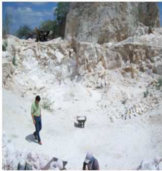
Figura 3a: Trabalho a céu aberto.
