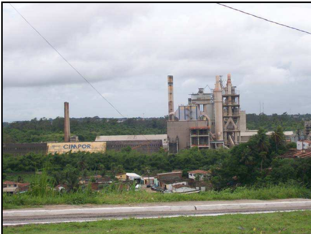
Figura 3 – Fábrica de cimento, 09/2009.
