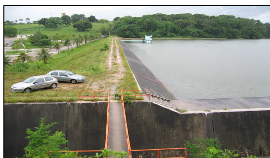
c) Reservatório Marés
