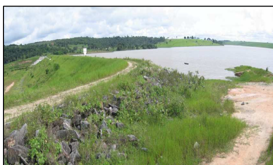
a) barragem do rio Gramame
