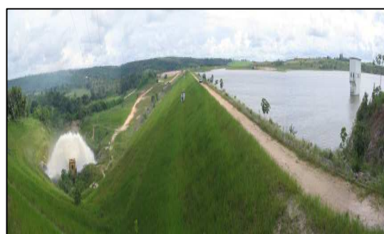
b) barragem do rio Mamuaba
