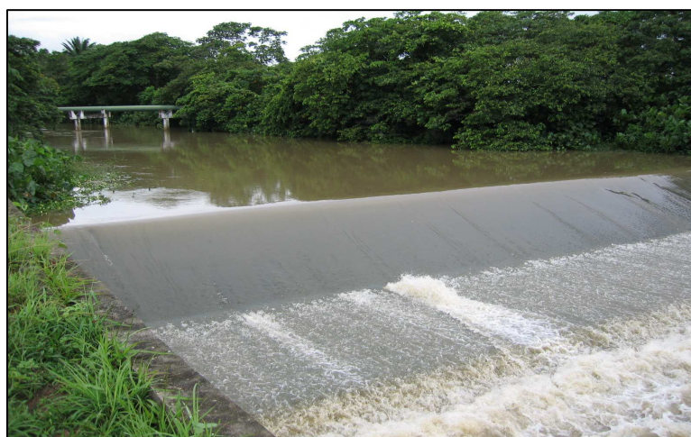
Figura 3.8 – Barragem de elevação de nível, no rio Gramame, a 6 km abaixo do reservatório Gramame-Mamuaba
