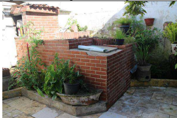
Alta renda Cisterna (16.000 l) com água da CAGEPA Reativação da cisterna desde o racionamento Água bombeada para caixas superiores
