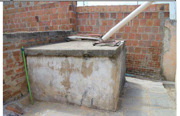
Baixa renda Cisterna (2.500 l) com água de chuva Uso permanente e exclusivo para dessedentação humana Água retirada manualmente com balde
